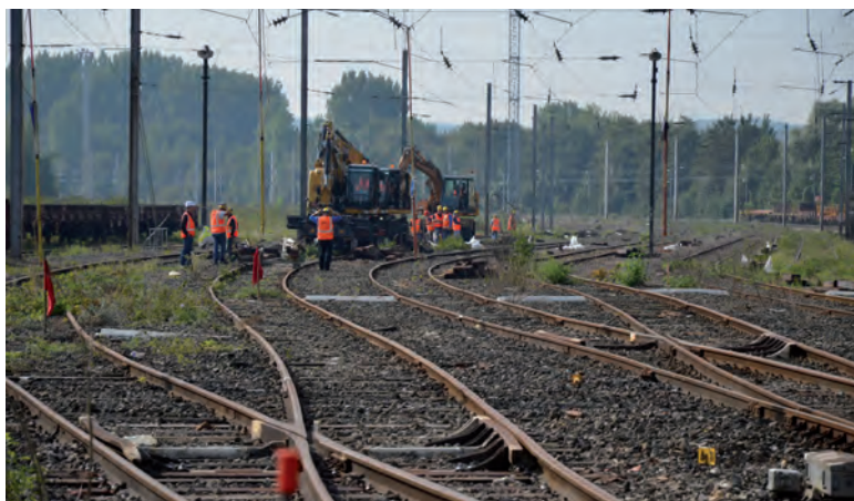
Travaux d'entretien ferroviaire
